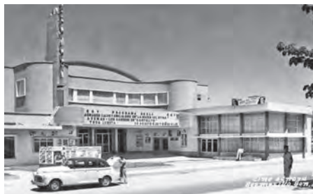
Cine Sonora (hoy demolido), Hermosillo, arquitecto Gustavo Aguilar (autor no identificado, 1947). Fuente: AHUS
