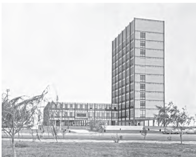
Imagen de la Torre de Rectoría ya construida. Fotografía: Álvaro Ríos
