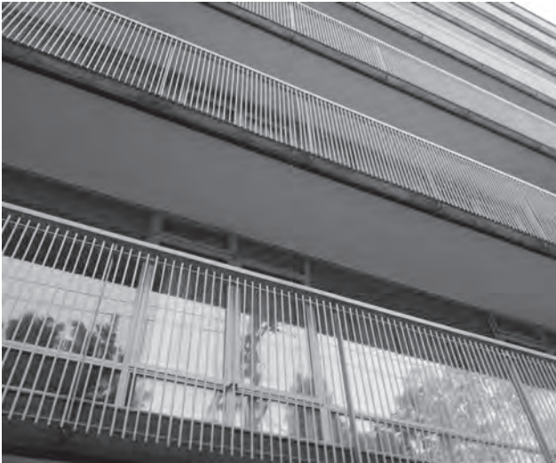
Vista de los balcones del edificio ubicado en Mazatlán núm. 36. Edificio proyectado por el ingeniero Boris Albin en 1968 y que en 2016 continúa en muy buen estado de conservación. Fuente: Colección personal, 2013
