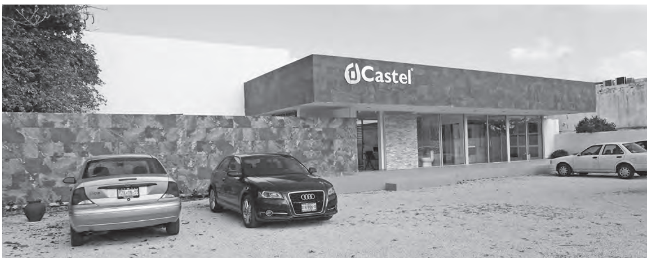
Remodelación de la casa Chapur para una tienda de materiales en 2014. Fotografía: EMGC, 2014
