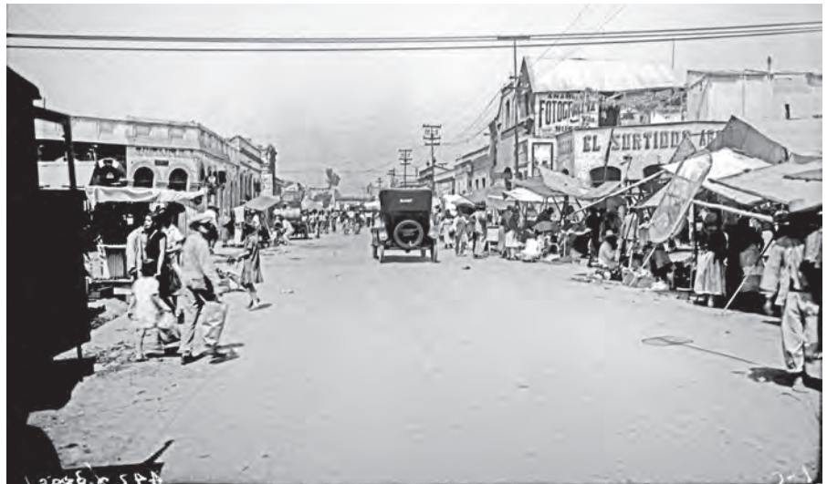
Calzada Jesús Carranza, en la colonia Anáhuac, 1928. Fuente: DGST
