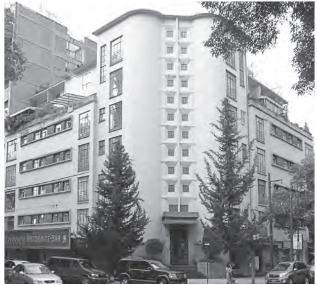
Edificio "Sevilla", Emilio Castelar núm. 31 y Galileo, del ingeniero y arquitecto Francisco J. Serrano. Fotografía: MBR, 2014
