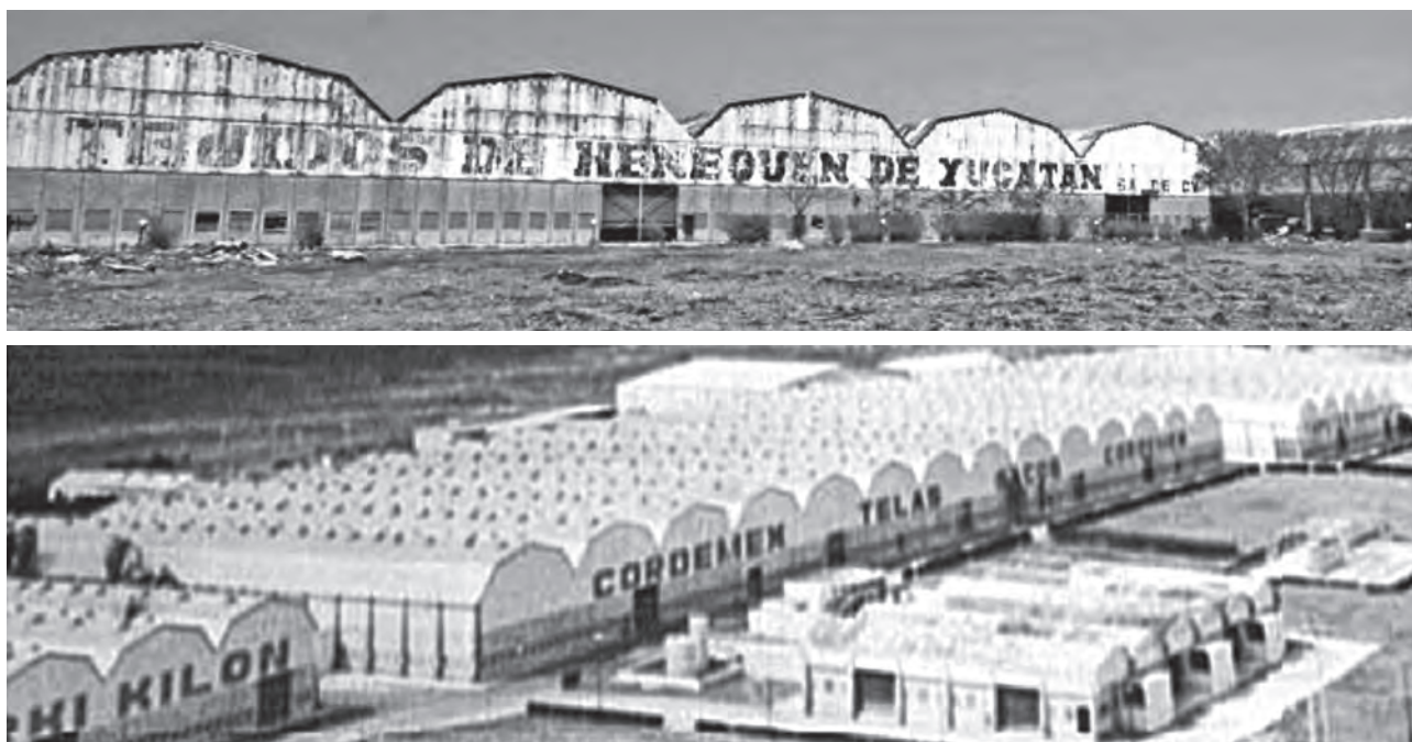
Fotografías de las naves industriales de la fábrica CORDEMEX, durante su funcionamiento y su estado actual. Fuente: Archivo Municipal de Mérida (arriba) y MTPG (abajo), 2015
