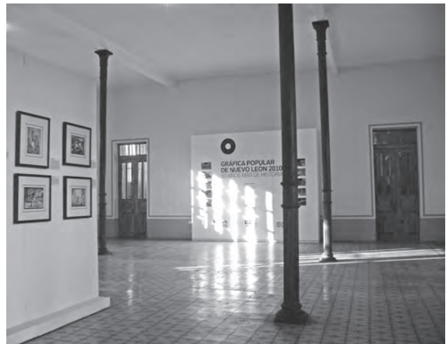
Primera fase de la modernidad constructiva: columnas metálicas y pavimentos de mosaicos de pasta (1905) como accesorios en el vernáculo edificio colonial conocido como “Casa del Campesino”. Fotografía: Penélope Montes, mayo de 2000
