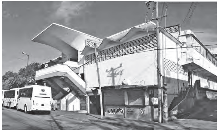
Fachada principal Mercado Grande, Coatzacoalcos, Veracruz, construido en 1963. Fotografía: HKV, 2014
