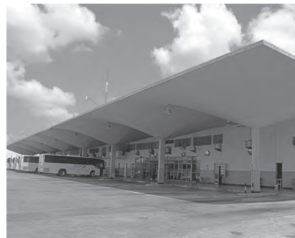
Andenes de la Estación de Única de Autobuses "Fernando Vargas Ocampo". Fotografía: EMGC
