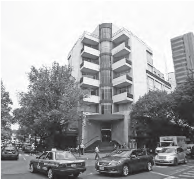
Edificio "Roel", Emilio Castelar núm. 107 y Julio Verne (1950-1952) del ingeniero y arquitecto Francisco J. Serrano. Fotografía: MBR, 2014
