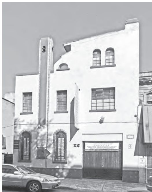
Transformaciones de la casa en Santa María la Ribera núm. 56, colonia Sta. María la Ribera. Fotografías: ISM, 2010 y 2017
