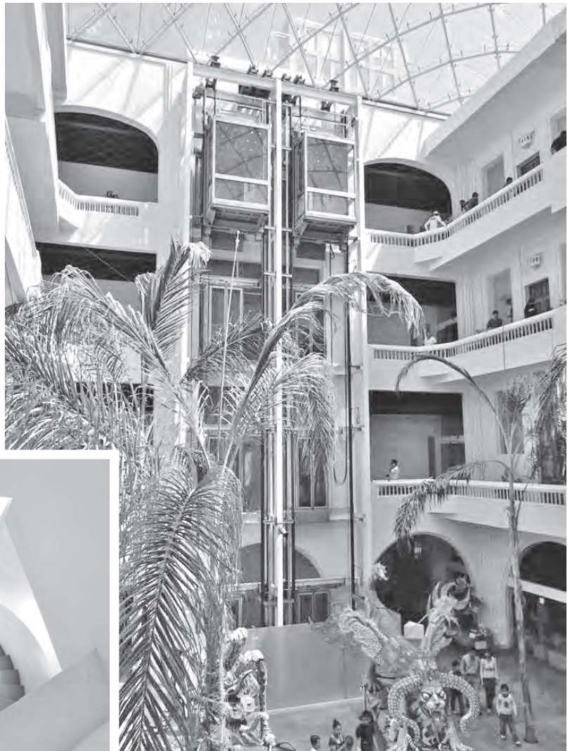
Vistas del inmueble ya intervenido, con el patio central cubierto y las escaleras contemporáneas. Fotografía: SA, 2014
