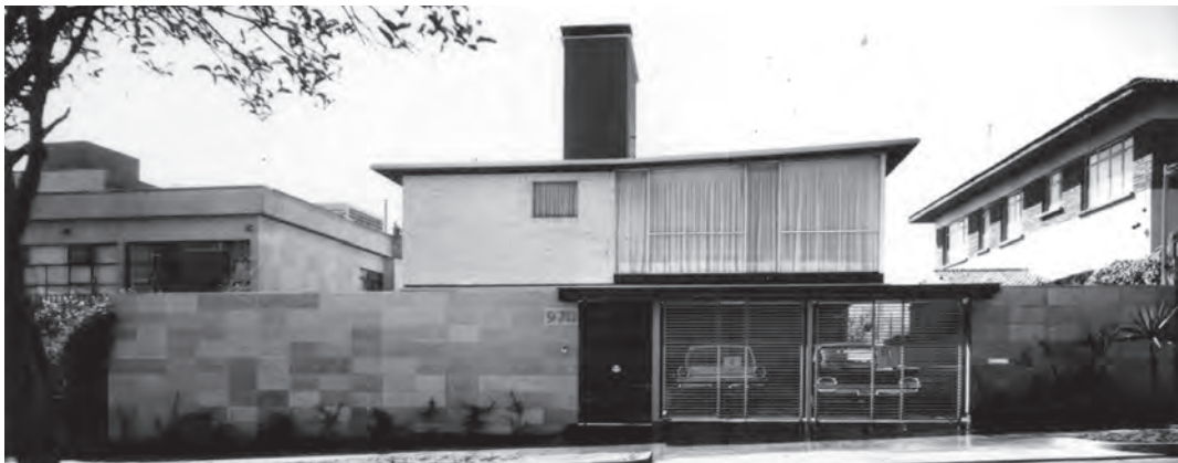
Vista de la fachada de la residencia en Avenida de las Palmas núm. 970, diseñada y construida por el ingeniero Boris Albin (foto de H. Mejía, ca. 1963). Fuente: AOIBA
