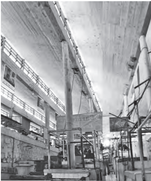
Vista interior de la techumbre del Mercado Sebastián Escobar, desde la rampa y la zona de carnes. Fotografía: HKV, 2013
