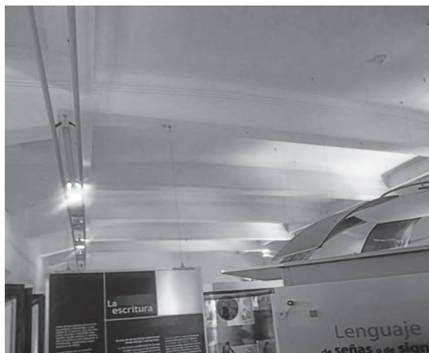
Salón de juntas con sistema de cubierta de concreto. Fotografía: FLV, 2015
