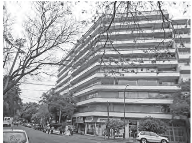
Edificio en Hegel núm. 237 y Newton (1968), del ingeniero Boris Albin. Fotografía: Manuel Berumen Rocha (MBR), 2014
