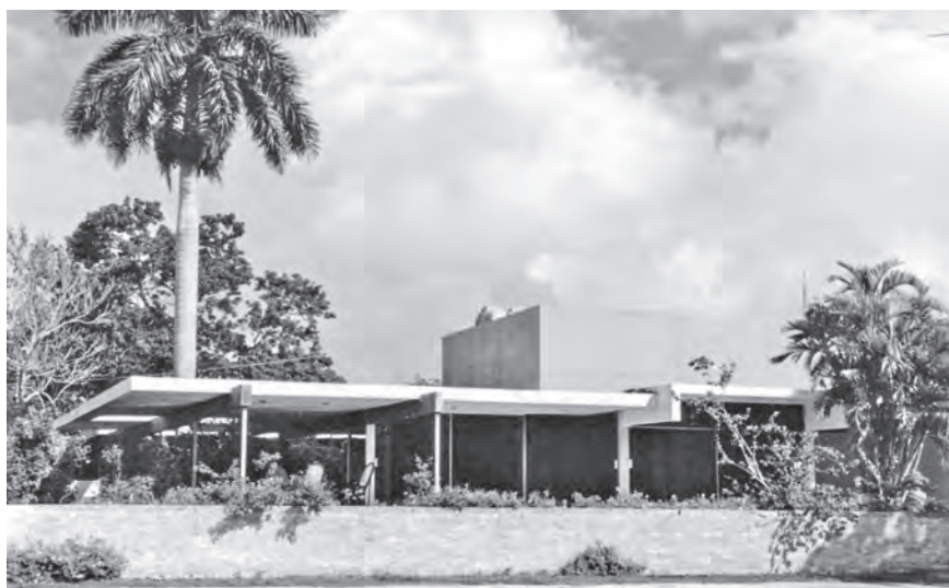
Casa García Ponce, proyecto del arquitecto Fernando García Ponce (1973). Fotografía: EMGC, 1997
