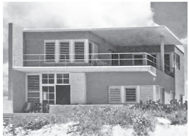
Casa de playa del señor Rocha en Puerto Progreso. Fuente: Archivo EMGC, década de los sesenta
