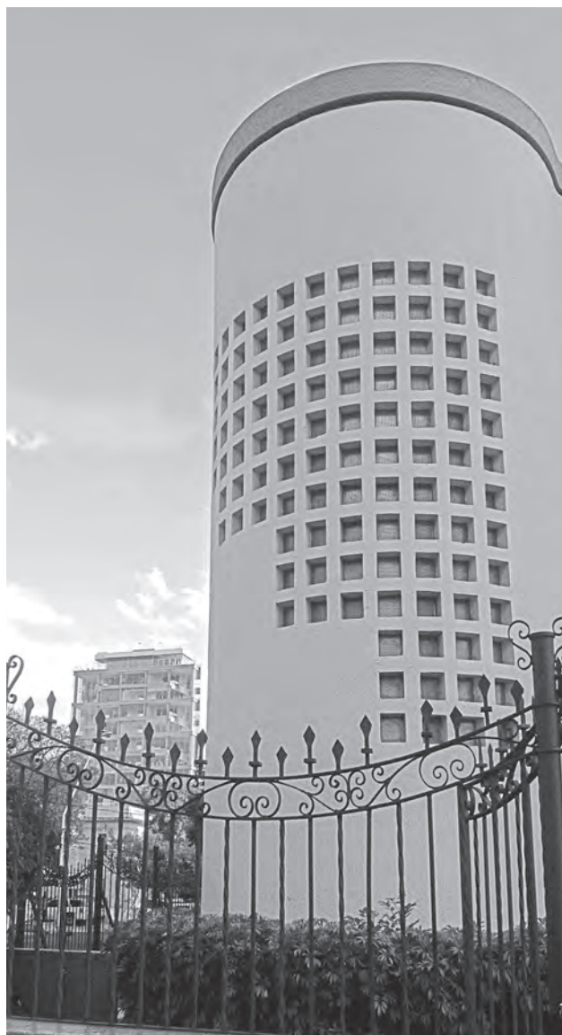
Casas en Unión y López Cotilla, uno de los conjuntos en donde empleó el vitrobloc y que se encuentran en buen estado de conservación en la esquina surponiente de la Av. Unión y López Cotilla. Fotografía: APC
