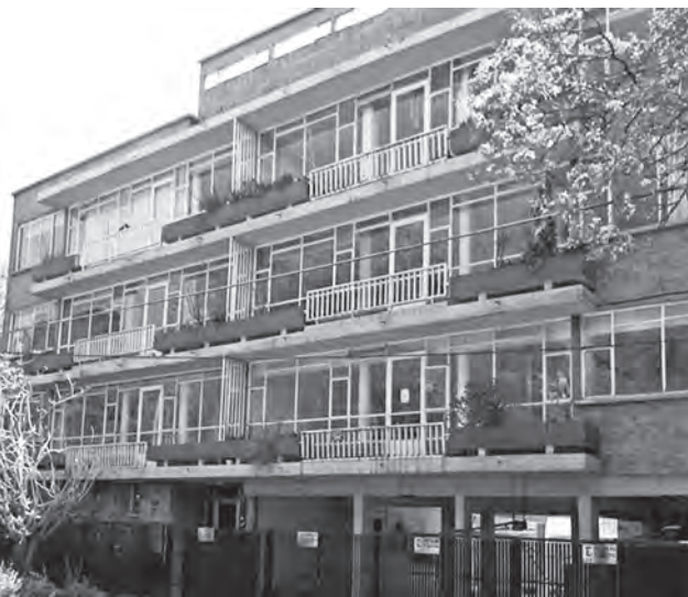
Edificio en Galileo núm. 125 esquina con Horacio (1954). del ingeniero León Dryjansky. Fotografía: MBR, 2014
