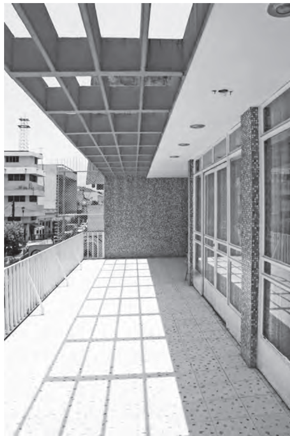
Fachada, escalera y terraza de la casa de Alberto Gutiérrez Domínguez, 1960. Fotografías: Hans Kabsch Vela (HKV), 2011
