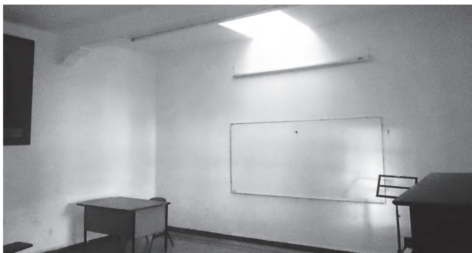
Sistema de iluminación para aulas en la Escuela de Bellas Artes (EBA) de la Universidad Autónoma Benito Juárez de Oaxaca (UABJO). Fotografía: FLV, 2015
