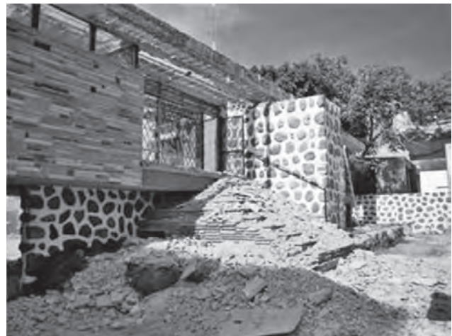
Demolición de la casa Madrigal Salazar, San Luis Potosí. Fotografía: JVR, 2012
