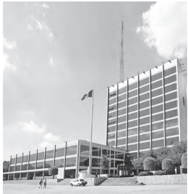
Nueva Imagen de la Torre de Rectoría luego de su intervención. Fotografía: Efraín Aldama Villa
