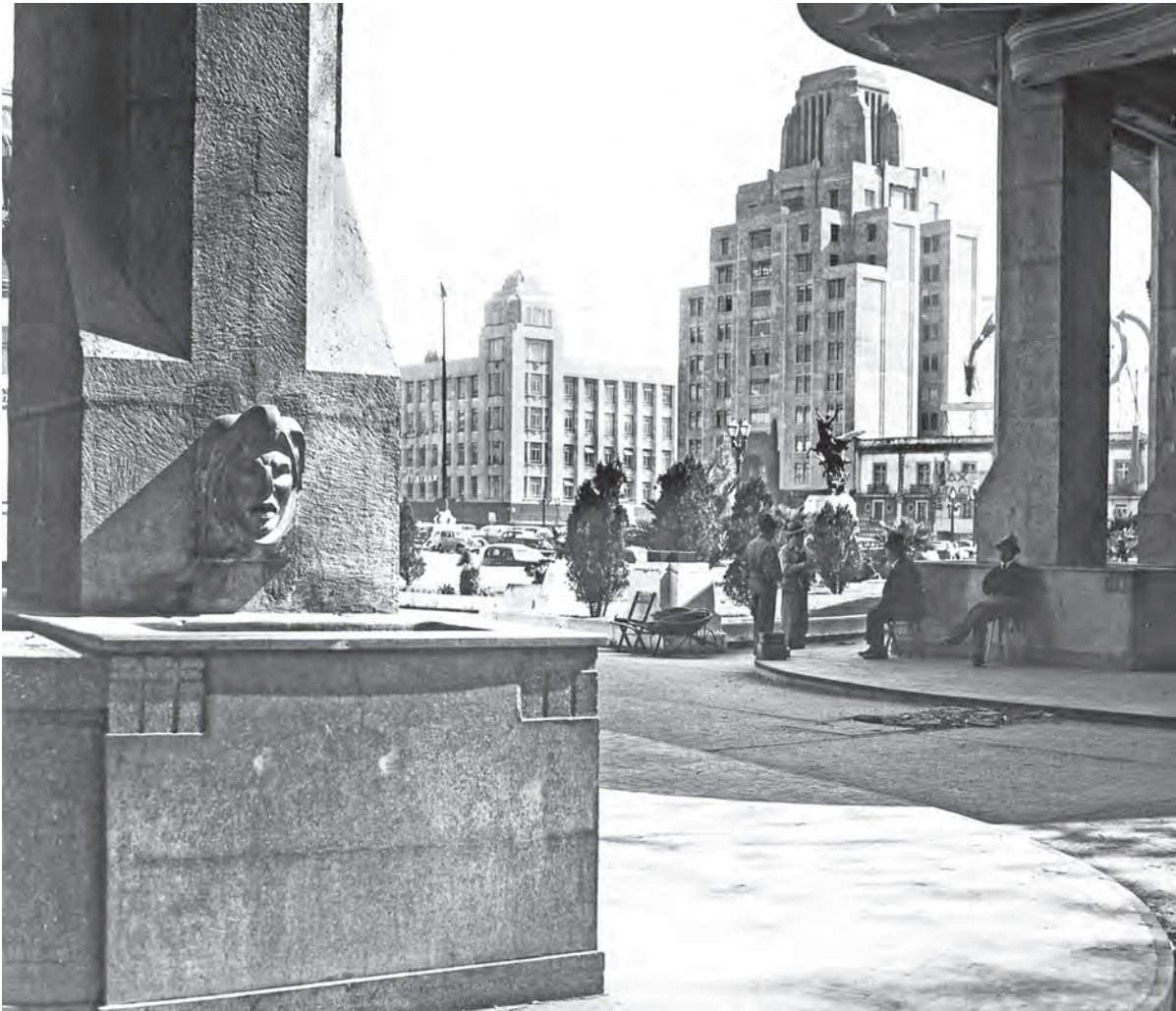
Edificio La Nacional , Ciudad de México (1929-1934) del arquitecto Manuel Ortíz Monasterio. Fondo: Manuel Ramos
