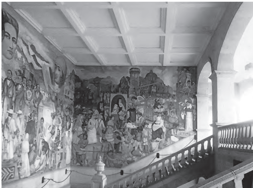
Cubo de escaleras con cubierta de concreto. Fotografía: Fabricio Lázaro Villaverde (FLV), 2015
