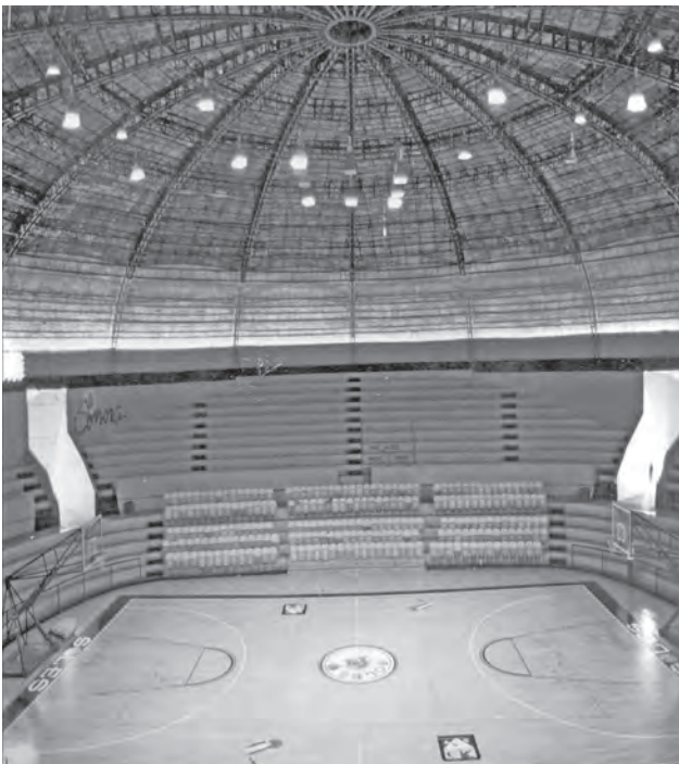
Vista interior del Gimnasio del estado luego de una remodelación, Hermosillo, arquitectos Joaquín Palacios, Hiram Marcor y Ernesto Ávila (autor no identificado, ca. 1992). Fuente: Archivo fotográfico Ernesto Ávila
