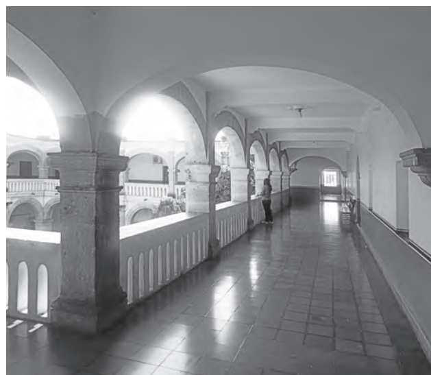
Corredor superior de EBA, que muestra el sistema de la cubierta y los materiales utilizados. Fotografía: FLV, 2015
