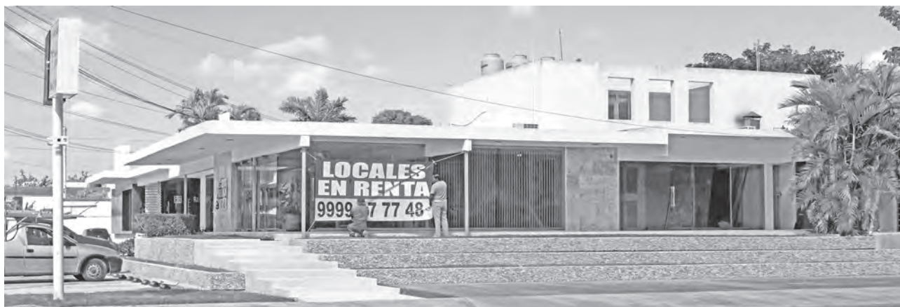
Casa García Ponce remodelada para locales comerciales en 2015. Fotografía: EMGC, 2015
