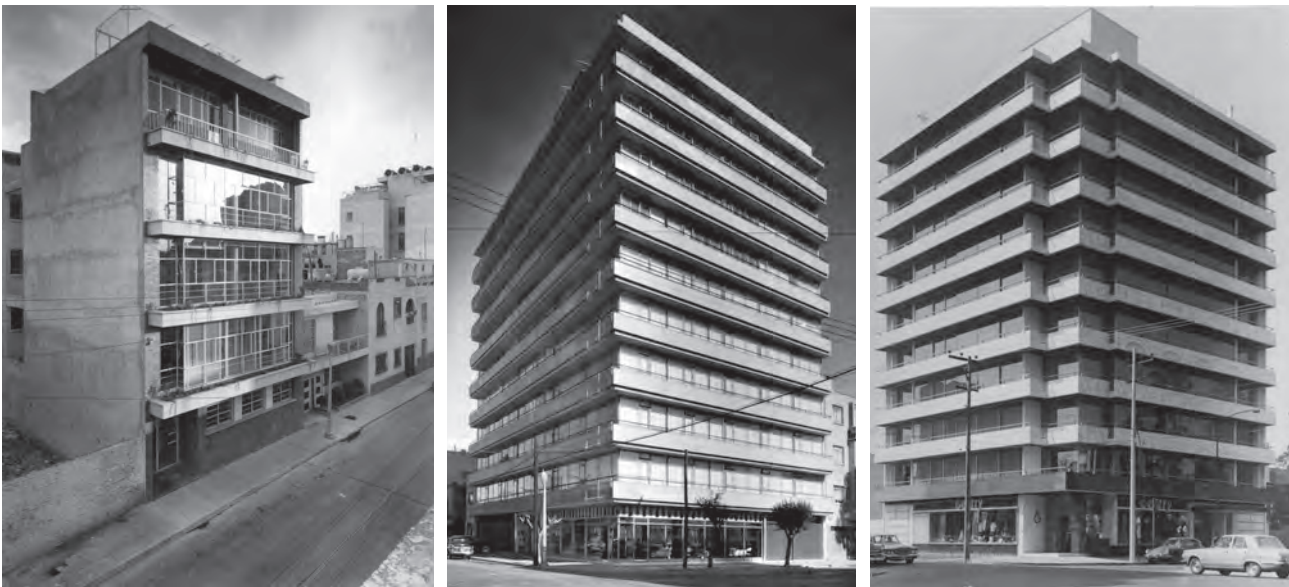
Vistas de las fachadas de Puerto Real núm. 38 (foto de 1950), Mexicali núm.20 (foto de H. Mejía, ca. 1959) y Horacio núm. 604 (foto ca. 1969); tres ejemplos característicos de las distintas etapas que tuvo la obra del ingeniero Albin. Fuente: AOIBA
