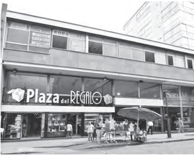
Ferretería Deutz Hermanos, de Cossío y Algara Arquitectos, 1965. Fotografía: JVR, 2013.
