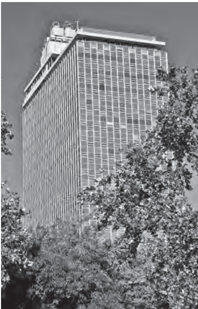
Cuarta fase: dominio de la tecnología constructiva a base de materiales de producción industrial –cemento, acero y vidrio– como en el Condominio Acero de 1959. Fotografía: Penélope Montes, mayo de 2000
