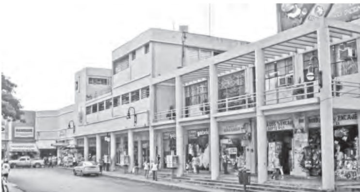
Equipamiento relevante de mediados del siglo XX: Terminal de Autobuses de Mérida, Hospital de Especialidades "Benito Juárez" (IMSS), Mercado "Lucas de Gálvez" y el Congreso del Estado de Yucatán. Fuente: Archivo personal de MTPG, 2016
